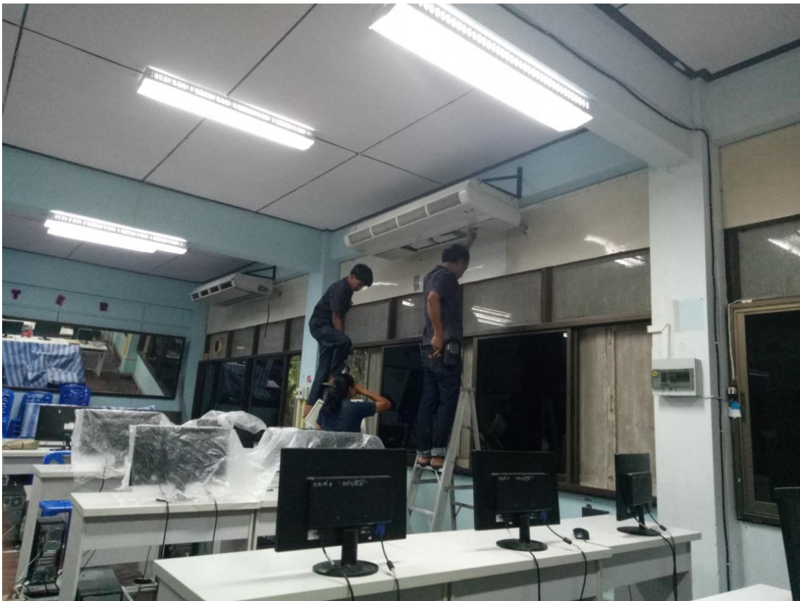
กิจกรรมปรับปรุงซ่อมแซมและเพิ่มศักยภาพครุภัณฑ์ห้องปฏิบัติการคอมพิวเตอร์
